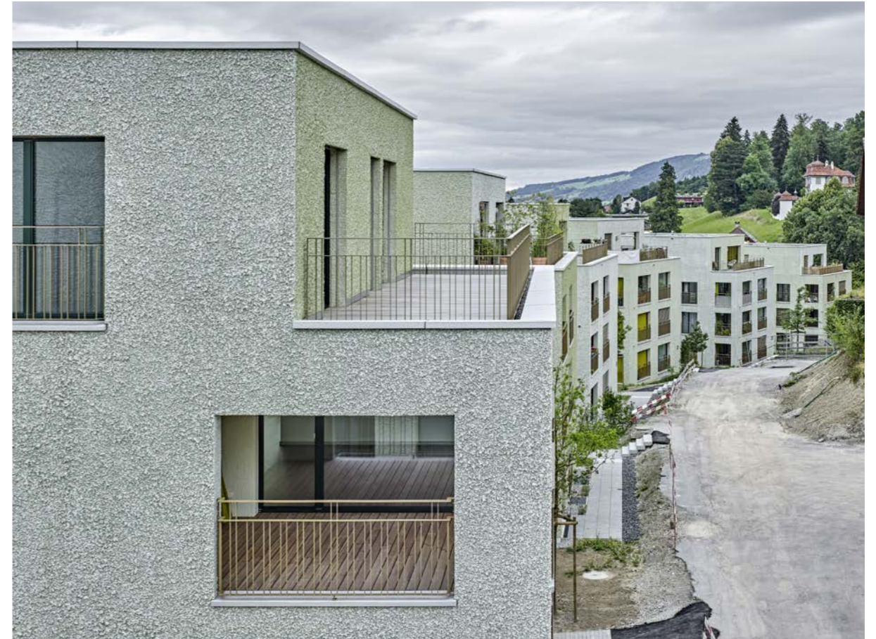
Gesamtübersicht der Erweiterungsbauten
