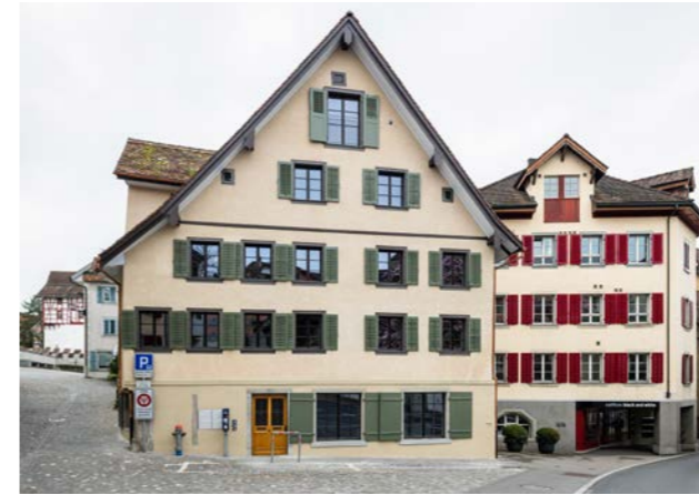
Hauptfassade zur Ägeristrasse. Kellenwurf und Farbfassung basierend auf Befunden anfangs 20. Jahrhundert Foto: Christian Herbert Hildebrand, fotozug.ch
