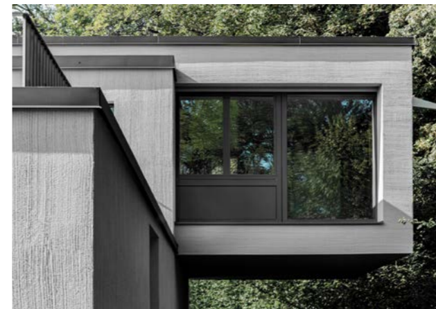
Ansicht Südfassade. Elternschlafzimmer im 1. OG auskragend über dem Studiogeschoss
