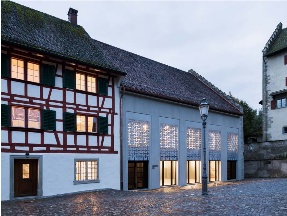
Städtlifassaden Pfarrhaus und Landenberghaus
