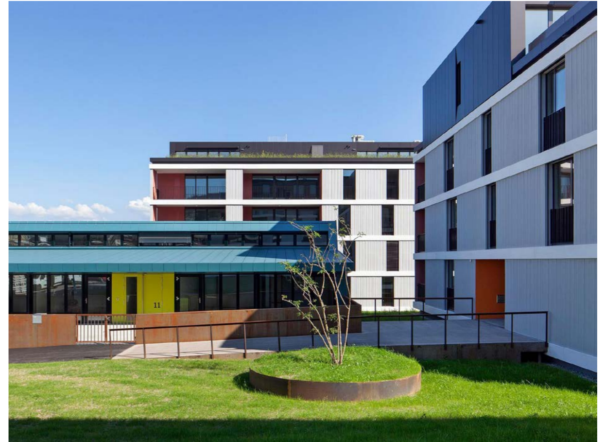
Ensemble: Grünraum, Kita und Wohnbauten
