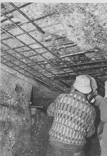
Bild 14. Sanierung Fahrbahnplatte
