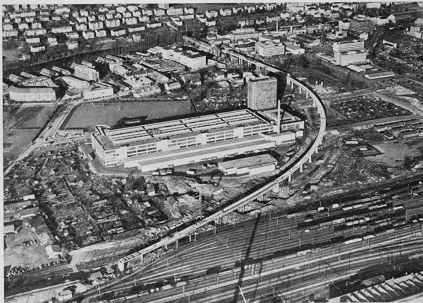
Bild 4. Der Hardturm-Viadukt im Bau, Flugbild vom 22. Februar 1967 aus Südwesten
