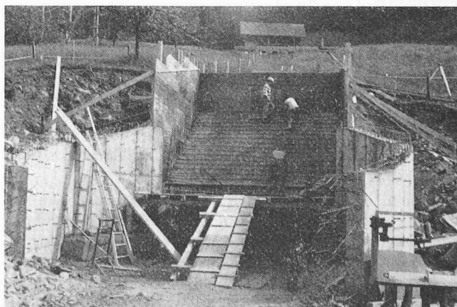
Bild 9. Erste Phase der Schachterstellung: Vom biegesteifen Schachtansatz (BSA) des Schachtes 14 ist hier ein segmentartiger Teil betoniert. Bergseits wird der Schachtaufbau armiert (Aufnahme: D. J. Bänziger, 2. 6. 1977)
