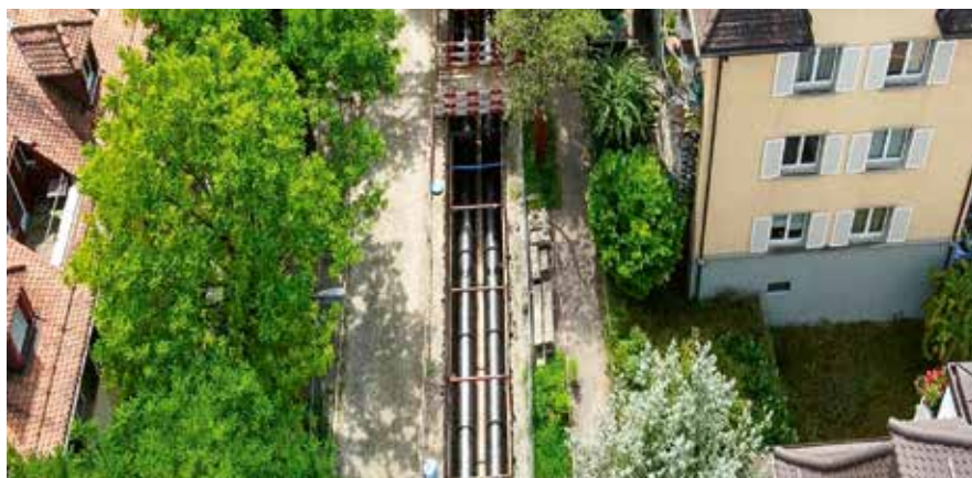
2 Die Feinverteilung der klimafreundlichen Fernwärme kommt voran.
