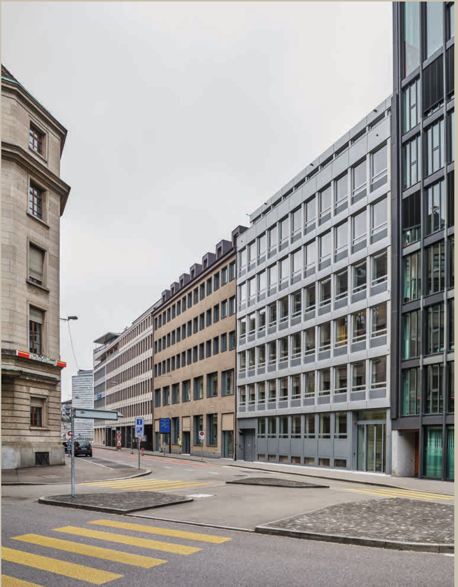
1 Ansicht zur Dufourstrasse auf der Höhe des Picassoplatzes in Basel.
