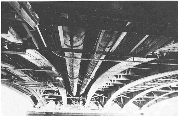
Bild 18. Untersicht der alten Brücke mit Werkleitungen
