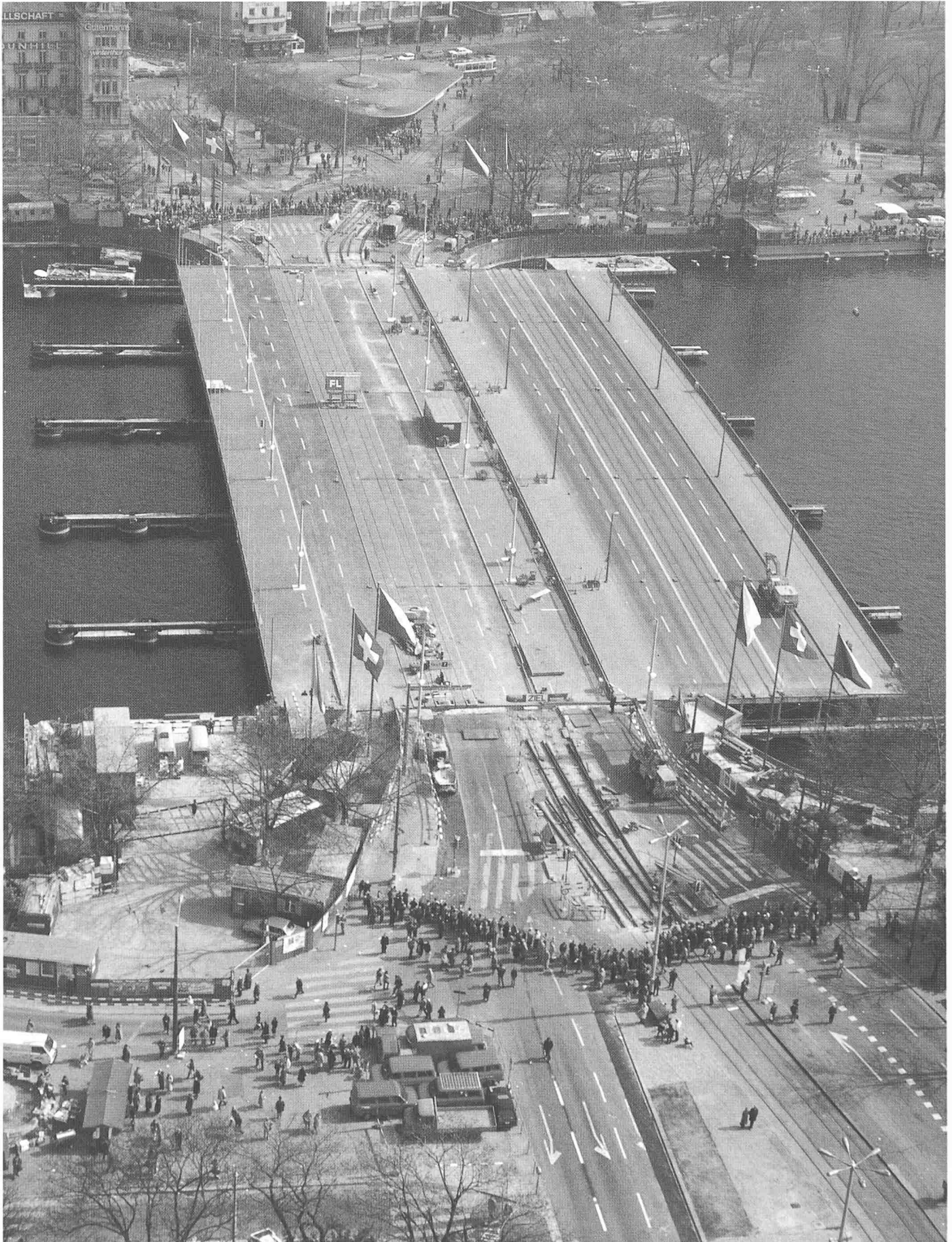
Bild 15. Luftaufnahme der Quaibrücken während des Verschubvorganges (17. März 1984), kurz vor Endlage
