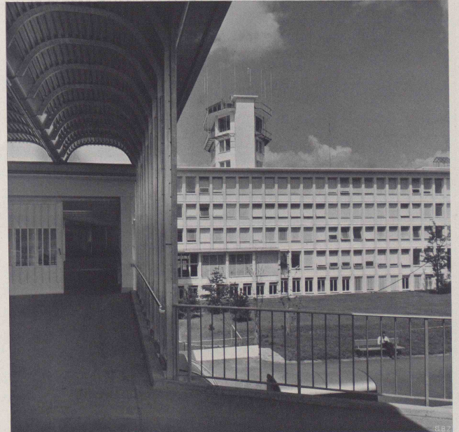
Bild 69. Ansicht des Bürotraktes, von der Vorfahrt aus
