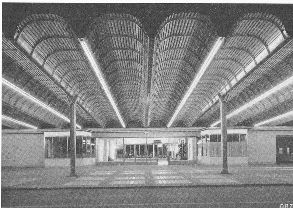
Bild 46. Neonbeleuchtung des Aluminiumvordaches
