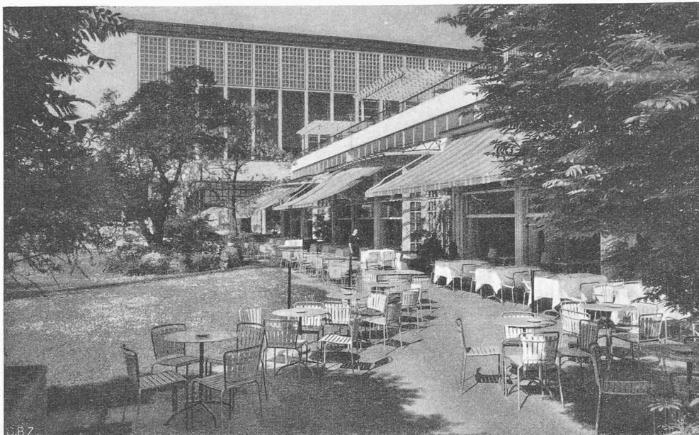
Abb. 4. Südseite des Gartensaals mit Blick gegen den Kongress-Saal. Auflockerung der technisch-strengen Baukörper durch kleinteilige Gitter-Roste als Vordächer über den Eingängen zum Gartensaal. Landschaftlich ungezwungene Gartengestaltung und Anordnung der Tische
