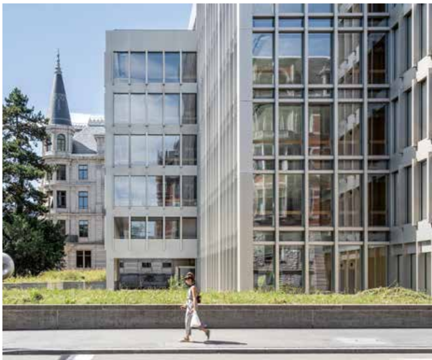
FOTO: FISCHER ARCHITECTEN
