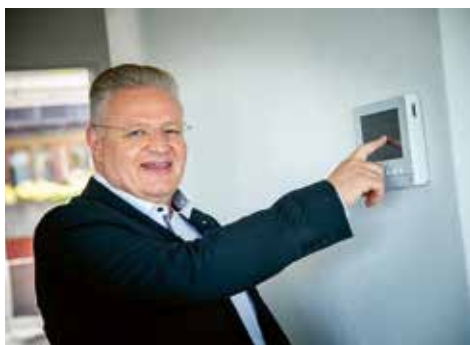
Yusuf Saba, ABB Schweiz, vor dem Gebäudeautomations-system in einer Wohnung
