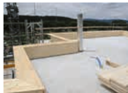
Terrassen- und Dachrandabschluss mit System UNI-Fix erstellt.
