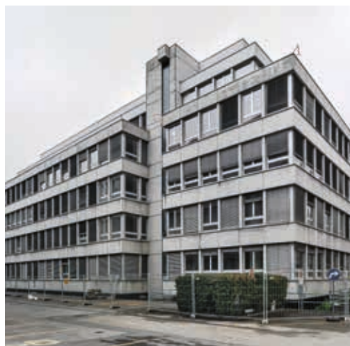
2 Das Bestandsgebäude vor dem Umbau.
