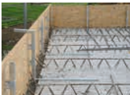
Terrassen- und Dachrandabschluss mit System UNI-Fix erstellt.
