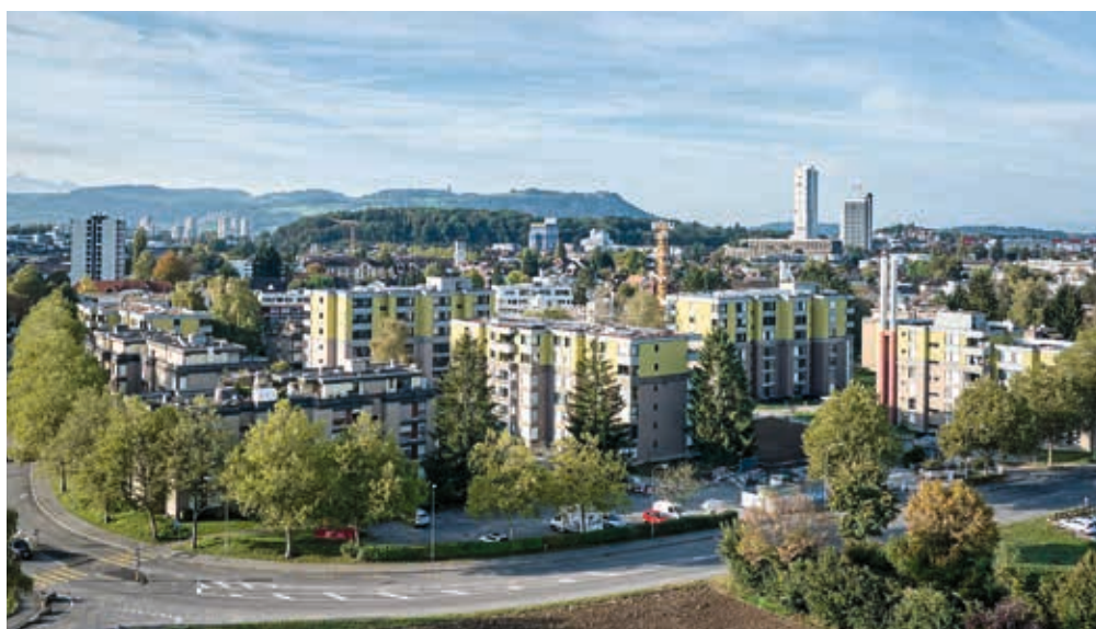
3 Die Siedlung Lindendorf II in Ostermündigen ist ein Ensemble aus zwölf Gebäuden. Le lotissement Lindendorf II à Ostermündigen est un ensemble de douze bâtiments.
