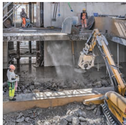
3 Grosszügige Öffnungen werden in die Betondecken geschnitten.
