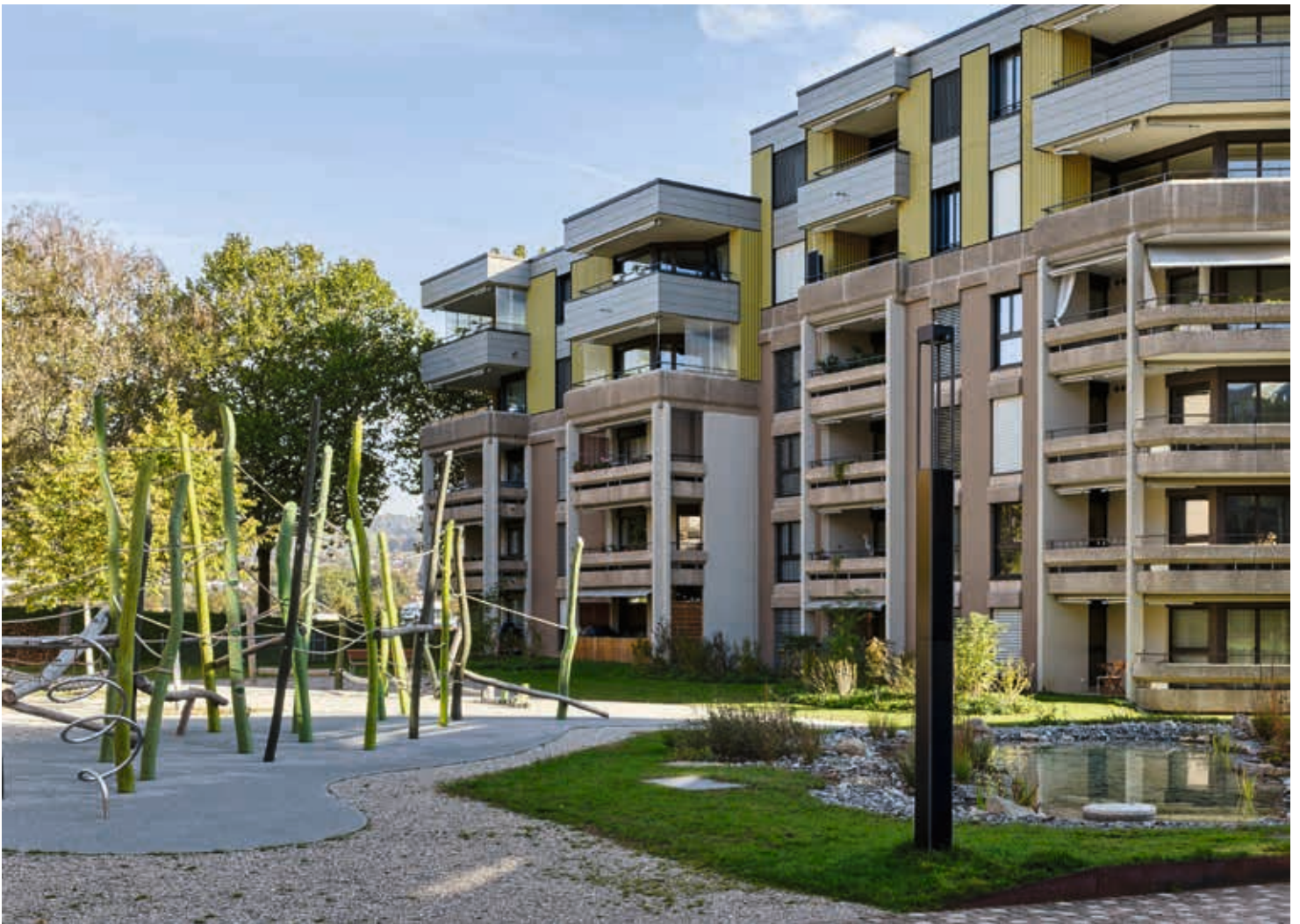
1 Die Bestandsgebäude von Heinz Kröppli aus dem Jahr 1981 wurden saniert und um zwei bis drei Geschosse aufgestockt. Les bâtiments existants de Heinz Kröppli, datant de 1981, ont été rénovés et surélevés de deux à trois étages.
