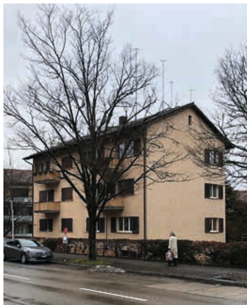
5 Die Erschliessung des Bestandsgebäudes aus den 1940er-Jahren erfolgte über den grünen Zwischenraum.
