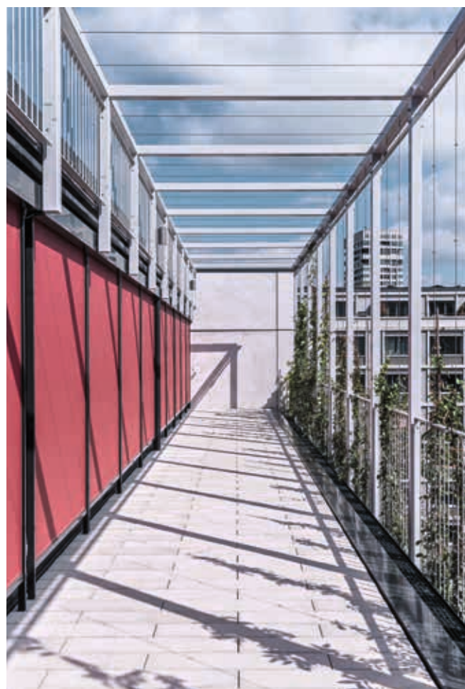
7 Die Fassade der oberen Geschosse wird zusätzlich mit Fassadenbegrünung verschattet. Les façades des étages supérieurs sont ombragées par des structures végétalisées. FOTO: R & D DÜRR
