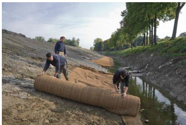
9b. Modification du lit et des berges (photos O. Zimmermann)
