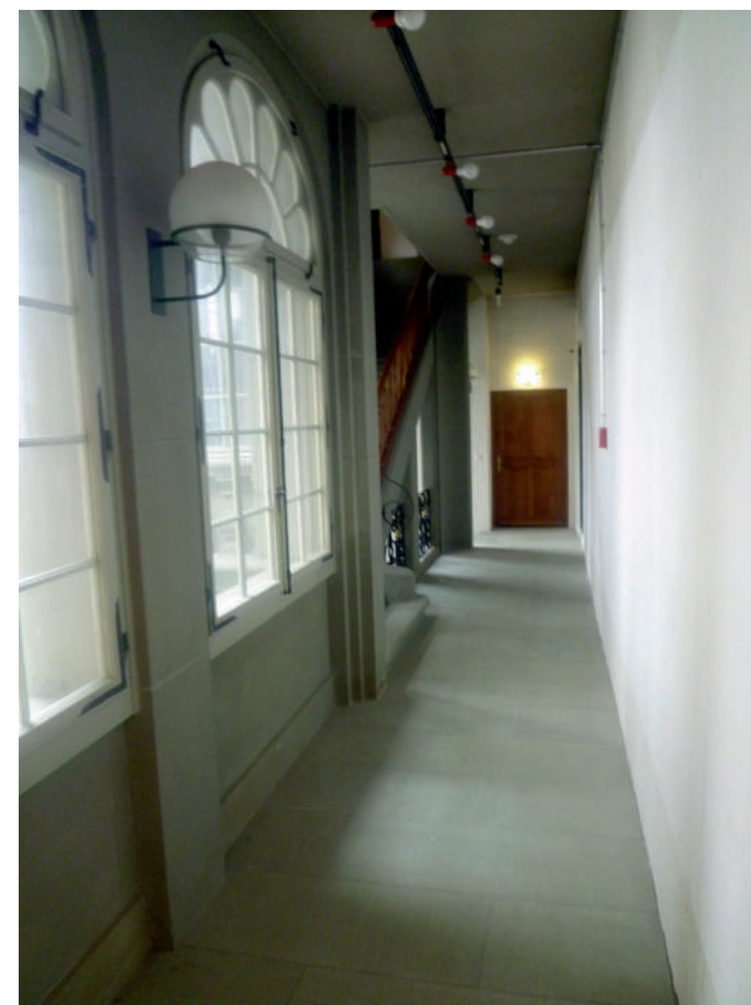
Verbindungsflügel Vorderhaus Treppenhaus im dritten Obergeschoss.
