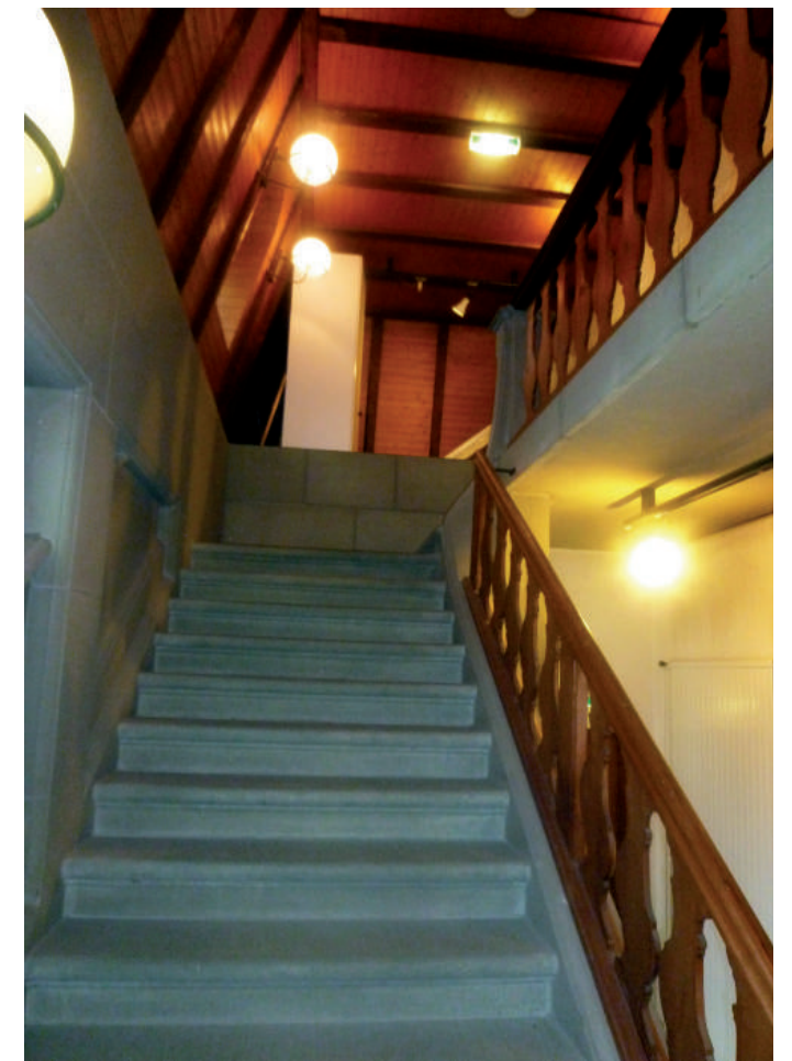
Treppenhaus, Abschnitt vom dritten ins vierte Obergeschoss mit ausgezeichneten Dockengeländern aus Holz.
