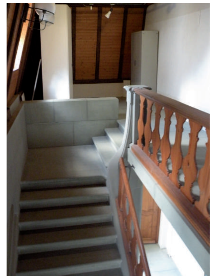
Treppenhaus, viertes Obergeschoss mit Zwischenpodest und Austritt.
