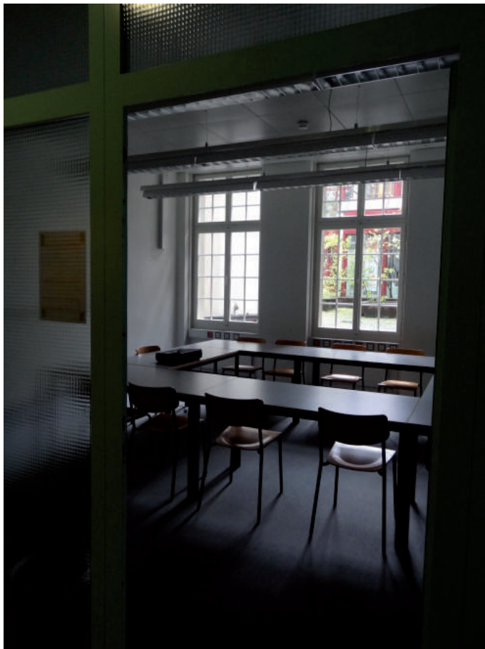
Zweites Obergeschoss, ehemaliges Antichambre, durch Stahl-Glas-Konstruktion in Korridor und Zimmer separiert.
