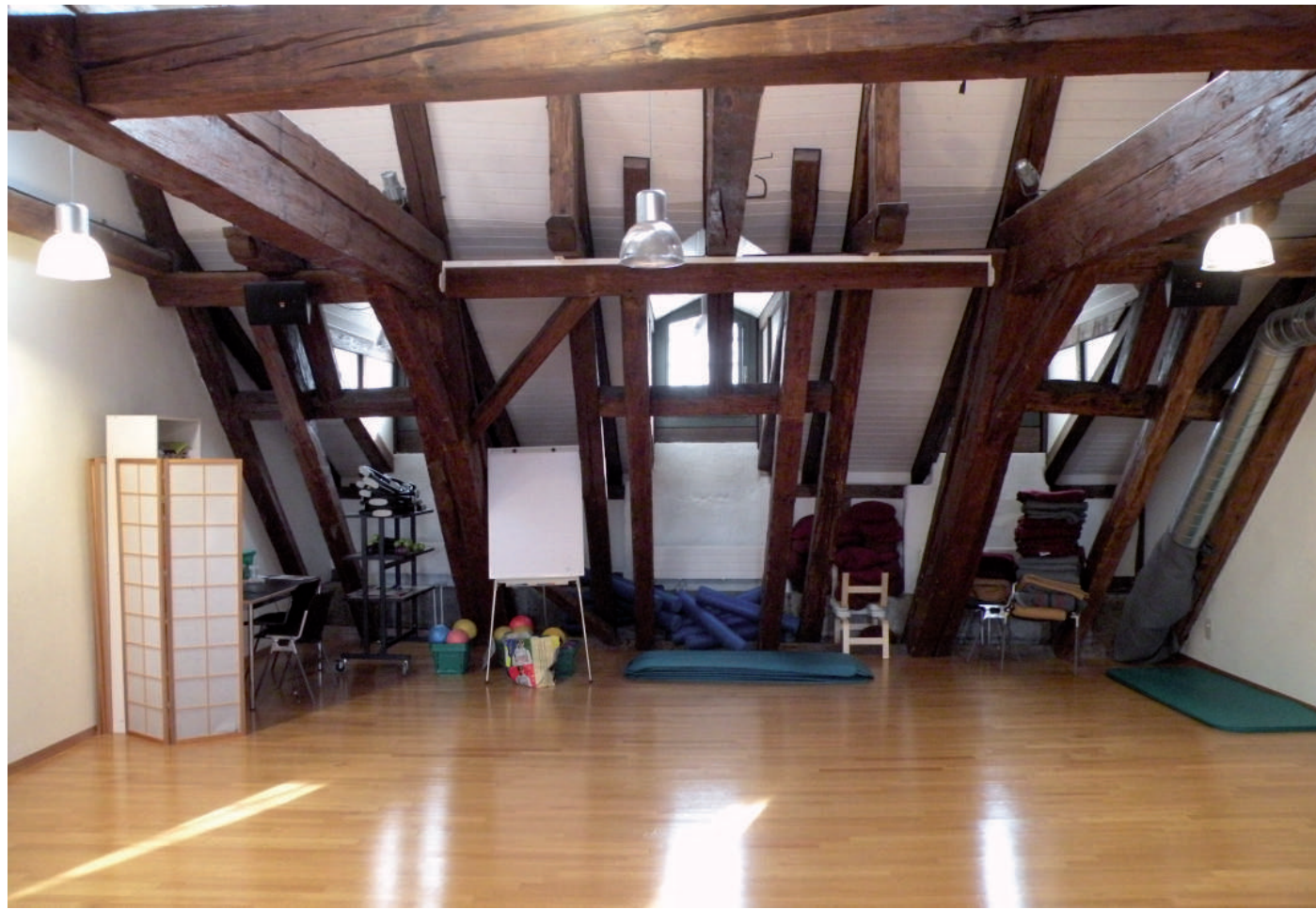
Dachraum mit liegendem Dachstuhl von 1746-1749, Ansicht Richtung Süden (oben) und Ansicht Richtung Norden (unten).
