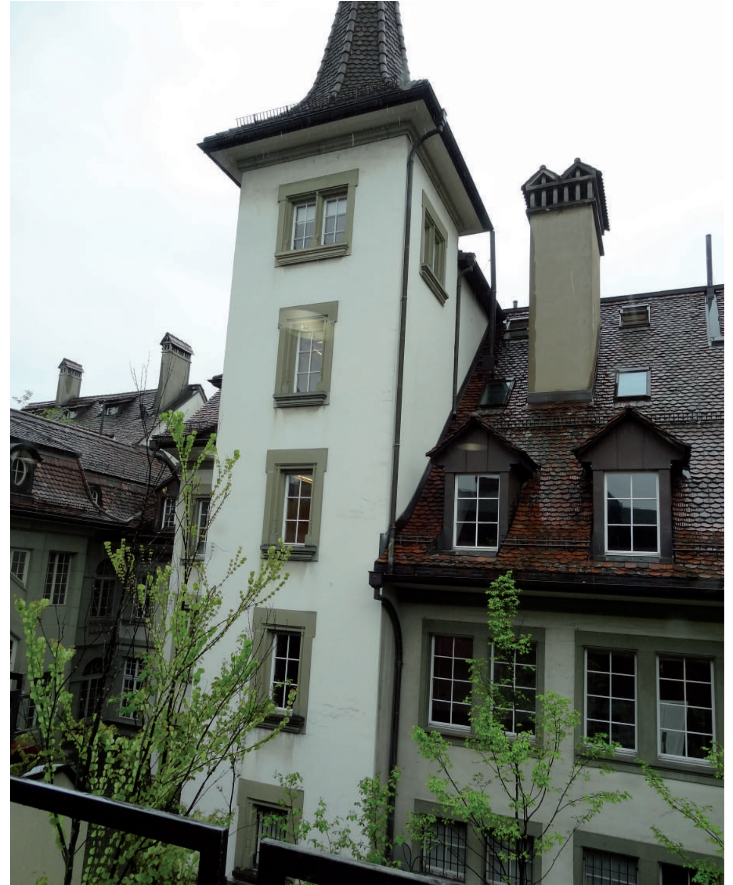
Rekonstruierter ehemaliger Treppenturm von 1596, Hofseite.
