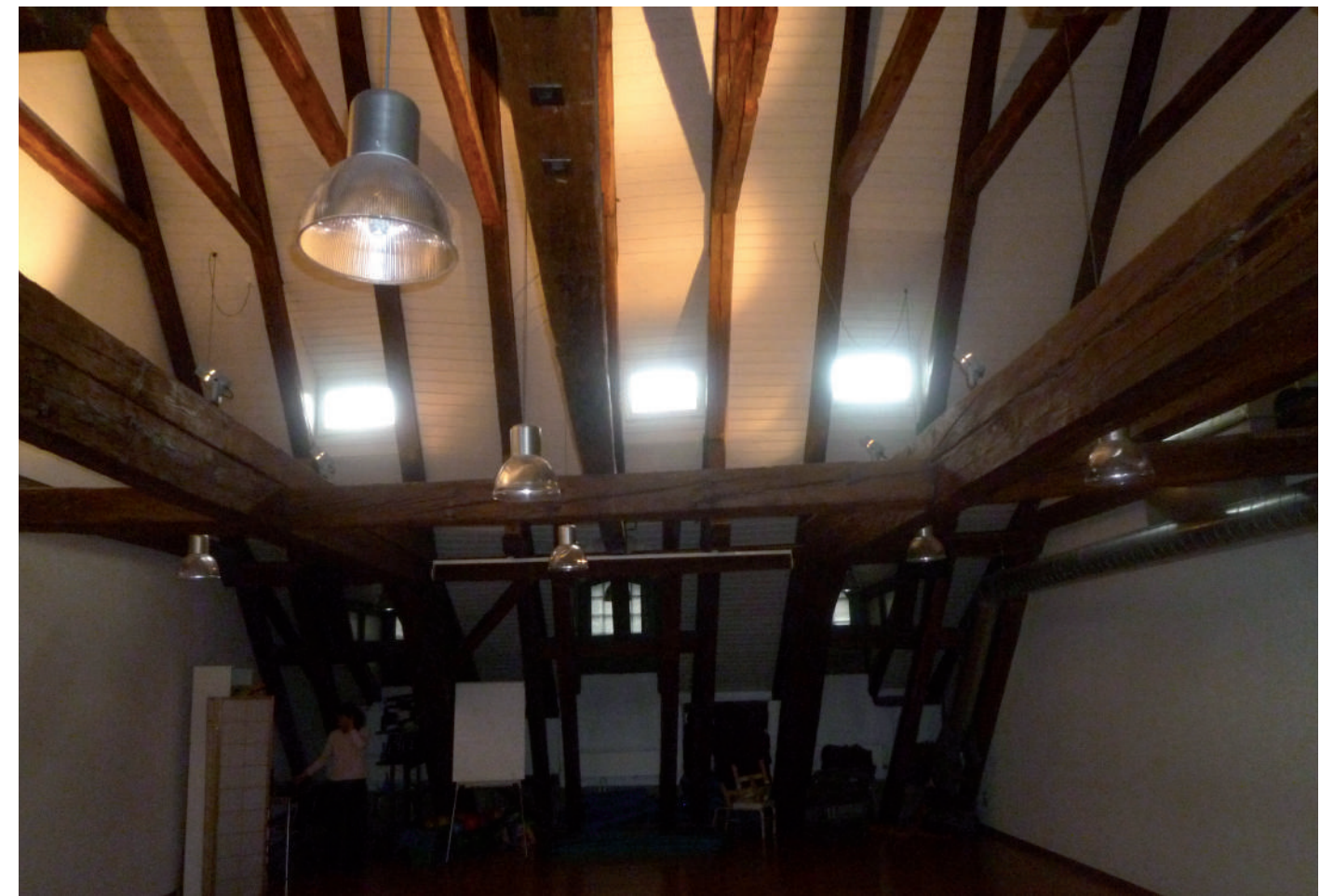
Dachraum Kehl- und Hahnenbalkenlage
