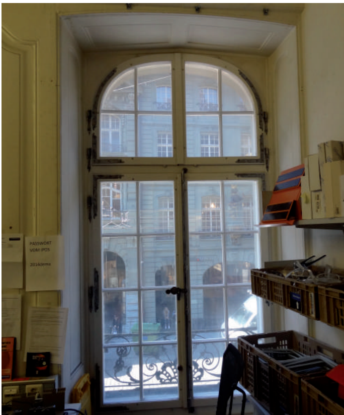
Fenster zweiflügelig, Flügel jeweils achteilig versprosst, und zweiteiliges Oblicht, vierteilig versprosst. Leibungstäfer mit Rechteckfüllungen.
