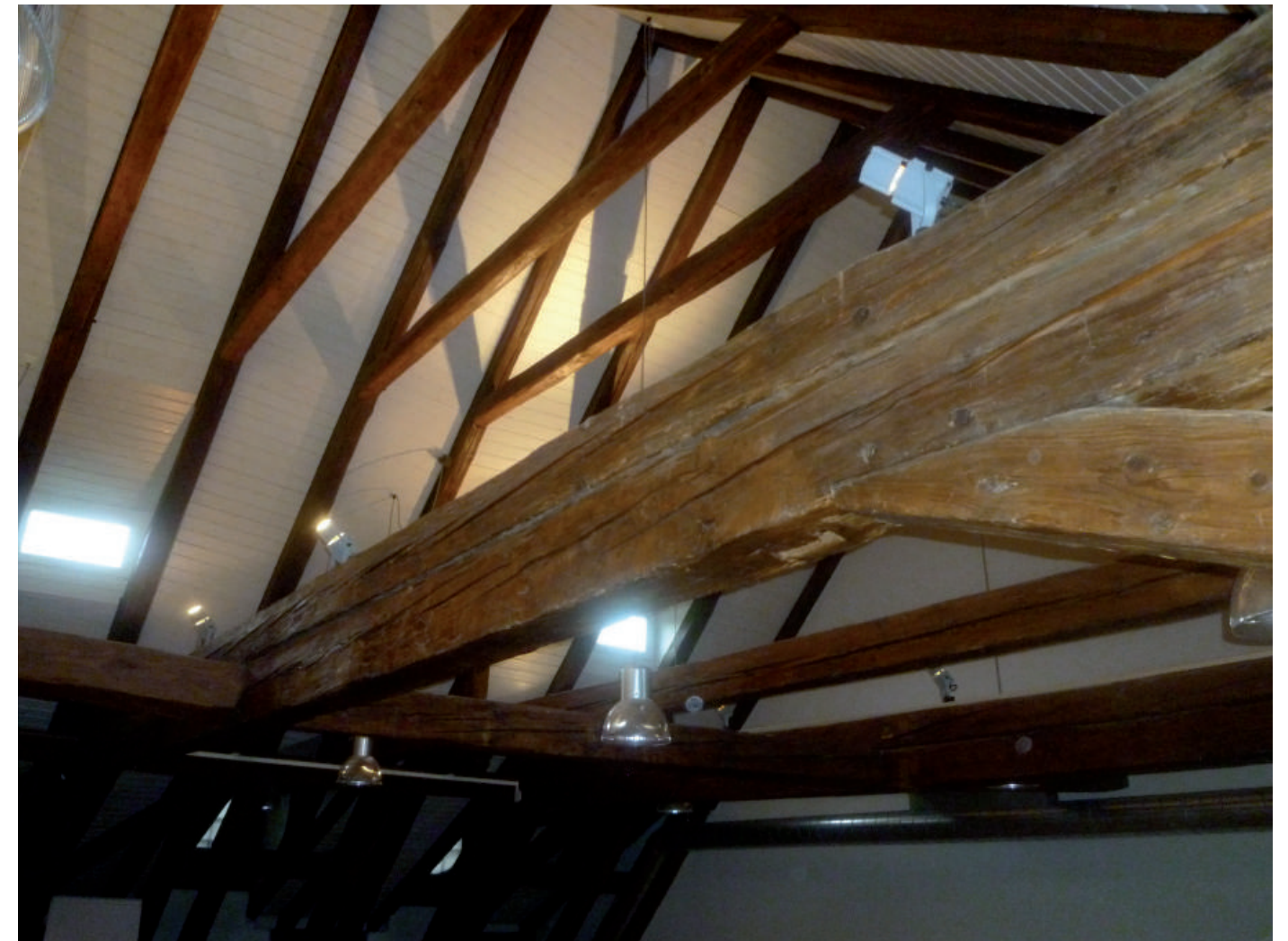
Dachraum Kehl- und Hahnenbalkenlage
