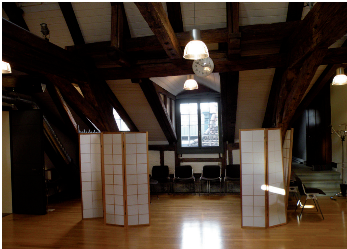
Dachraum mit liegendem Dachstuhl von 1746-1749, Ansicht Richtung Süden (oben) und Ansicht Richtung Norden (unten).
