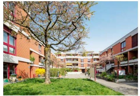
Wohnsiedlung Winzerhalde Zürich, Erneuerung nach SNBS, 2018.
