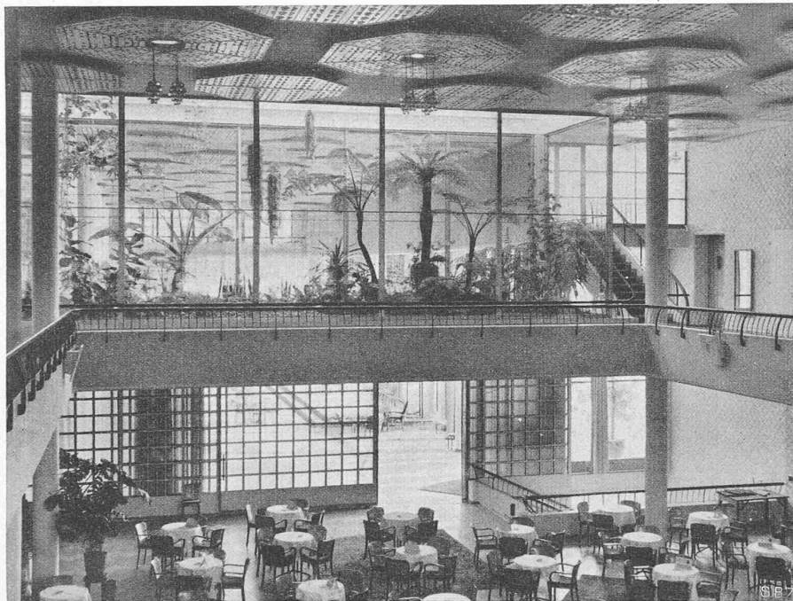
Abb. 29. Blick von der Galerie des Kongress-Foyer gegen das Konzert-Foyer, unten gegitterte Schiebewand als wegnehmbare Trennung, oben tropischer Wintergarten, rechts davon Treppen auf die oberste Freiterrasse
