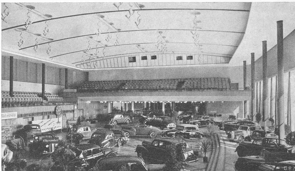
Abb. 33. Kongress-Saal, ohne Bestuhlung für eine Automobilausstellung eingerichtet. Blick gegen Foyer und rückwärtige Galerie, rechts Estrade von drei Stufen, die das «Ausleeren» des Raumes durch die Glaswand etwas eindämmt, wie die analoge Estrade im Konzertfoyer (Abb. 27 und 28)
