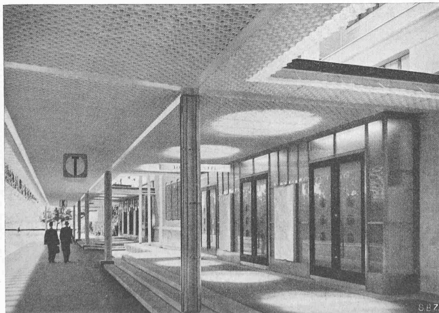
Abb. 20. Vordach vor den Haupteingängen. Das in sehr eleganten technischen Formen konstruierte Vordach ist durch rechteckige Ausschnitte von der Mauer des alten und des neuen Gebäudekörpers isoliert, es tritt somit als eigene technische Massnahme in Erscheinung, nicht als eine vom Baukörper ausgehende Portalbildung wie die Portale und Vorhallen klassischer Art. Statt Ornamentierung zeigt die Untersicht eine reizvoll spielende Textur aus weiss gestrichenen Blechstegen
