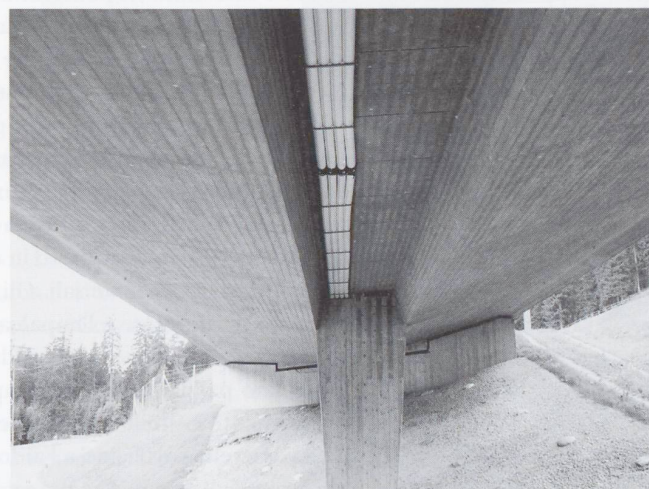
Ponte sul raccordo all'autostrada A13 a Sufers, 1996, Conzett Bronzini Gartmann
