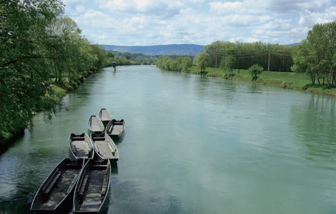
Der sanierte Hagneckkanal bietet Schutz für den Menschen und Mehrwert für die Natur.
