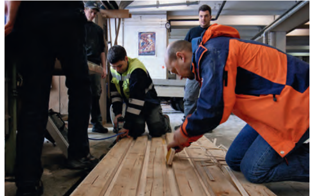
Die Schalung ist so konstruiert, dass das Feuer die Bretter in den Zwischenräumen nicht zu stark ausdünnt.
