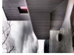
32 Bootshaus Peterij Oberrieden Seestrasse bei 63, Oberrieden Jörg Gimmi gimmivogt architekten eth sia gmbh, Zürich Baudirektion Kanton Zürich
