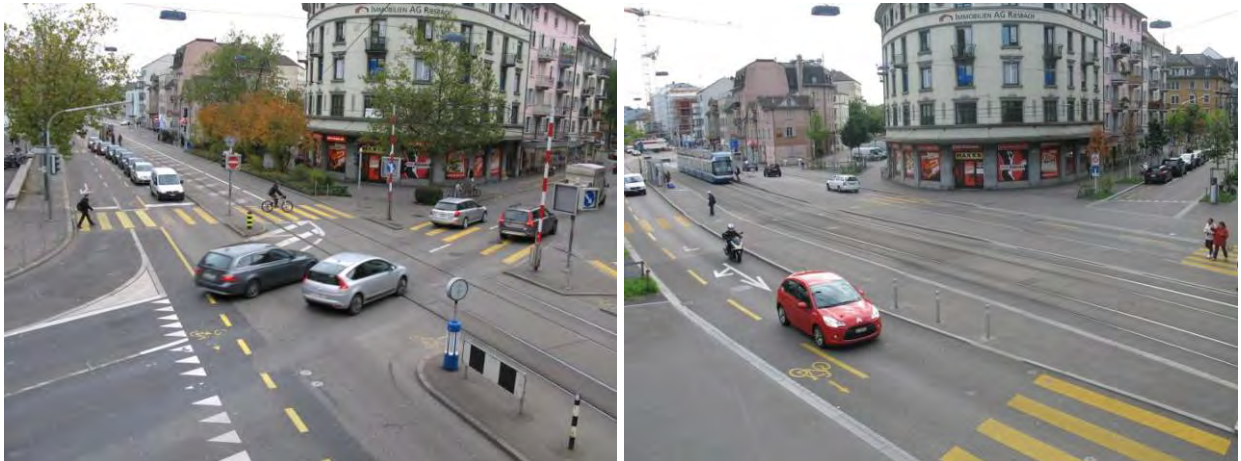
Abbildung 44: Sihlfeldstrasse, Nov. 2008 (links) und Sept. 2013 (rechts): Umbau zu verkehrsberuhigter Quartierstrasse mit Tempo 30 und Gegenverkehr
