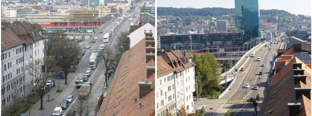
Abbildung 38: Hardstrasse, Nov. 2008 (links) und August 2013 (rechts): Neuer Fussgängerstreifen Bushaltestelle Hardplatz, sanierte Hardbrücke
